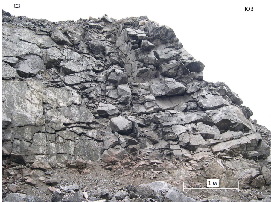
Рис. 9. Тектоническая трещиноватость (без видимой кинематики смещений) в карьере строительных материалов северо-западнее Каменногорска
